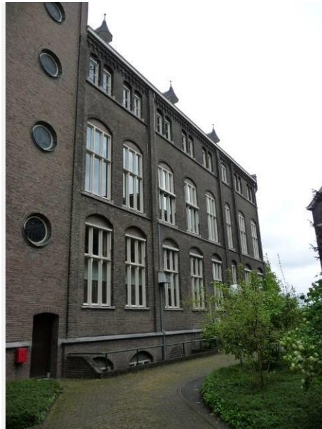
De zuidelijke gevel van de 19 e -eeuwse zuidvleugel
