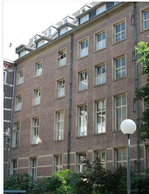
Noordgevel van de zuidelijke vleugel
