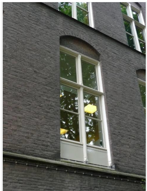
Oorspronkelijk raam in de oostelijke gevel
